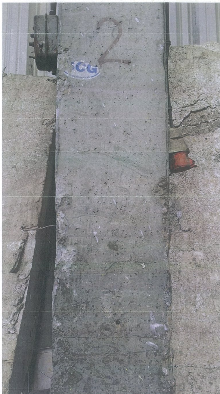
Слика 5.4 Уништен Репер бр. 2 и рупа у зиду (репер који је обновљен са спољне стране)
